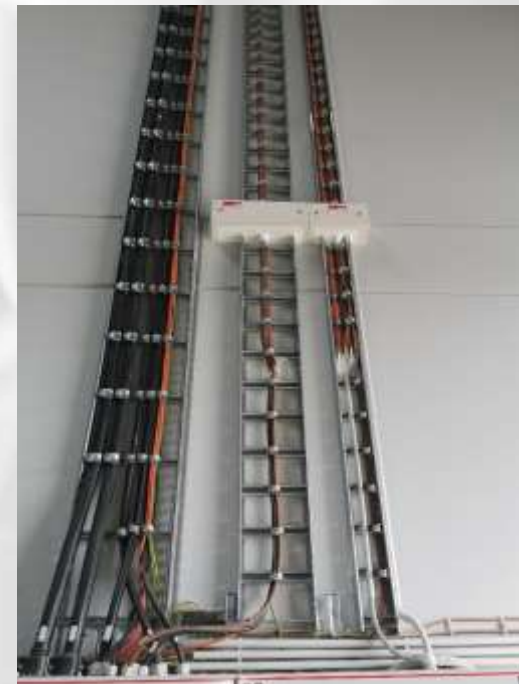
b) Meandrové dilatační uložení kabelů (viz článek 8.1.11 b) 2)
