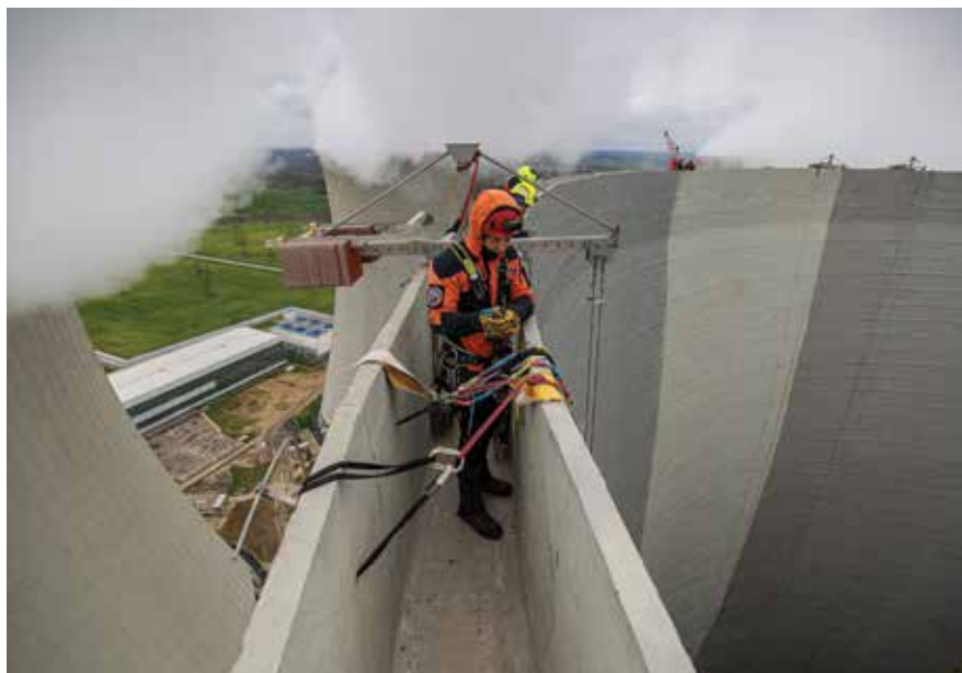
Výcvik HZS ČR v jaderné elektrárně Dukovany
